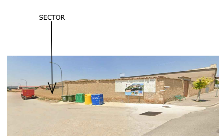
VISTA DESDE CALLE VEGA DEL CAMINO
